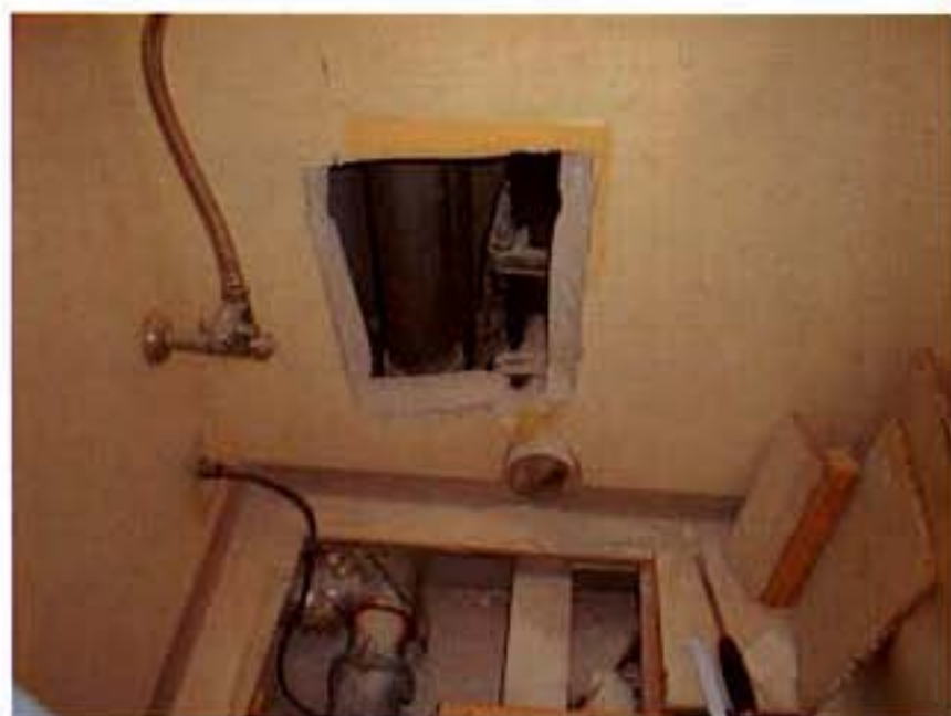
トイレ内 壁 (ALC) の開口
