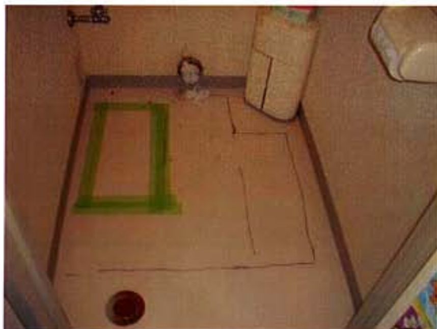
トイレ内 便器取り外し 床開口準備
